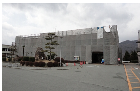
工事が進む今田まちづくりセンター
