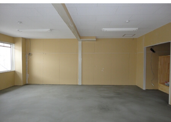
内装前のまちづくり協議会事務所
